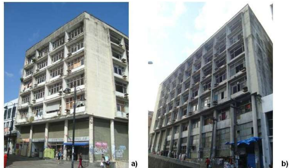
Figura 25: a) Edifício IPASE – fachada leste; b) Edifício IPASE – fachada norte. Fonte: Acervo próprio.
