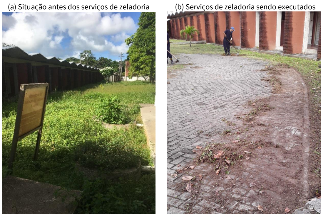
Figura 8 – Situação antes e durante a execução dos serviços de zeladoria
