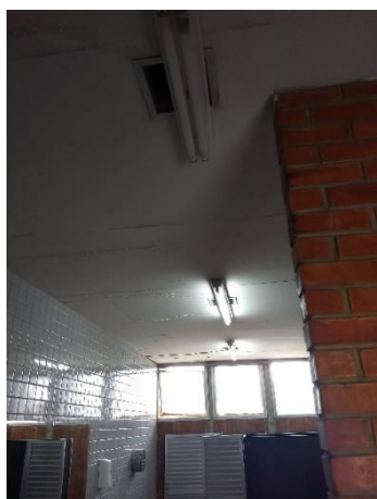
(a) Banheiro Masculino: luminárias
