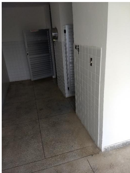
(a) Corredor de entrada banheiros no 1º pavimento
