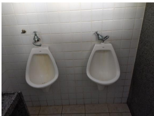
(a) Banheiro masculino térreo: trocar os registros do mictório por torneira de pressão
