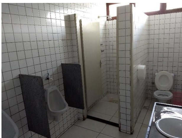
(a) Banheiro Masculino
