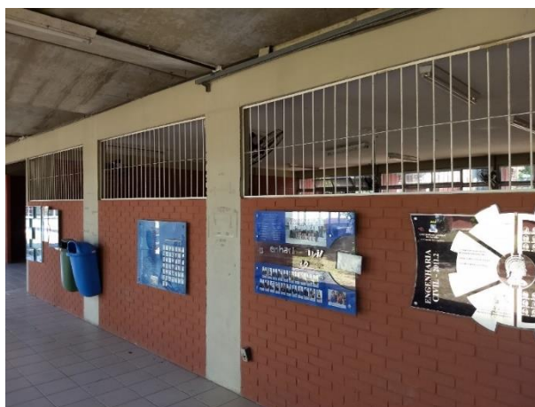
Figura 6 – Abertura nas paredes com grades para ventilação com segurança: necessidade de colocar janelas
