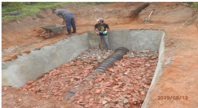
(A) detalhe da construção da fossa, câmara de fermentação e entulho.
