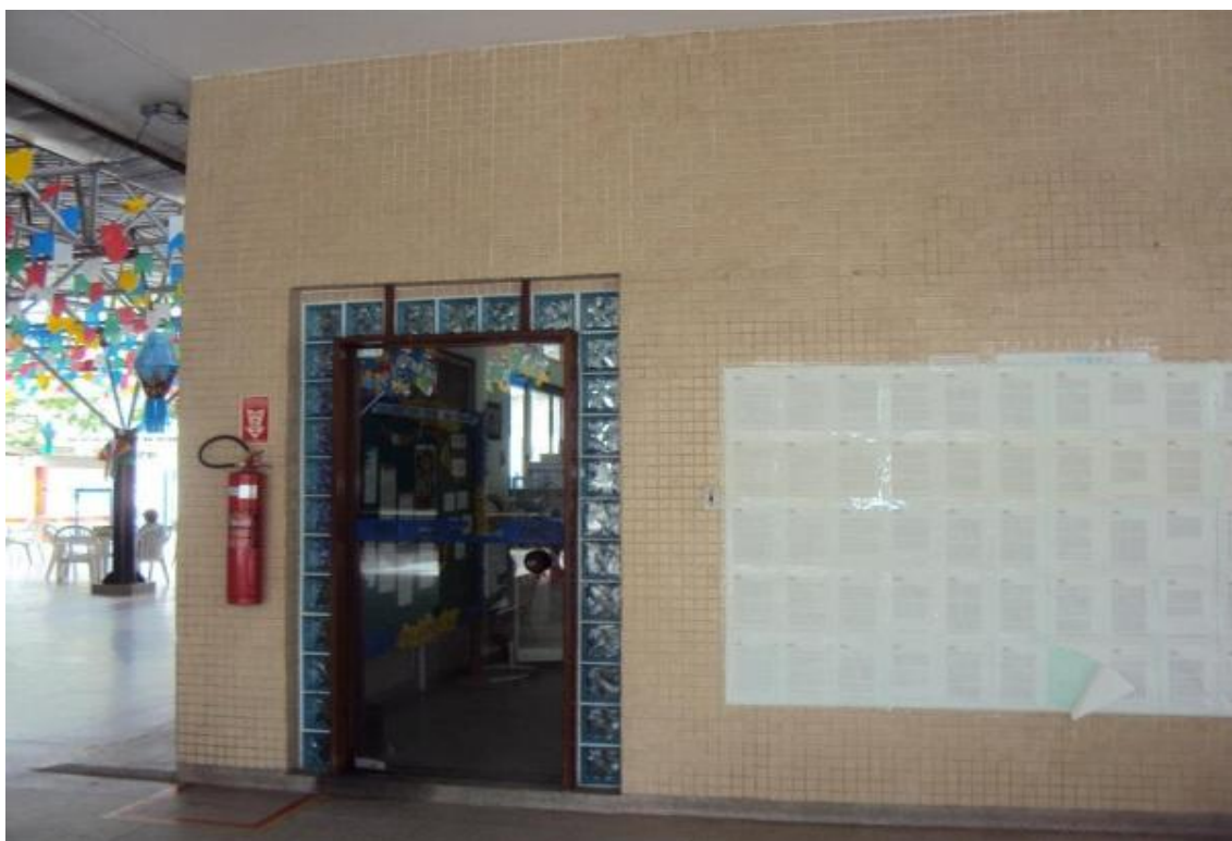
Figura 1 – Faixada da Biblioteca do SESC Centro João Pessoa/PB
