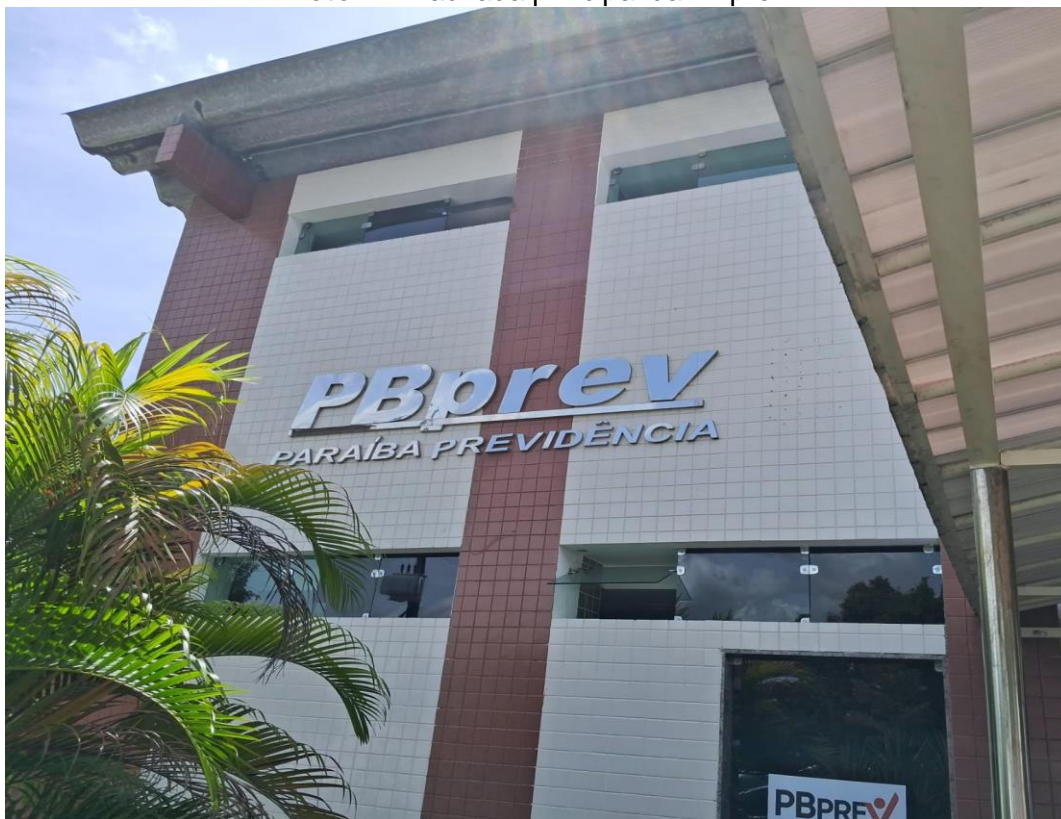
Foto 1 – Fachada principal da PBprev
